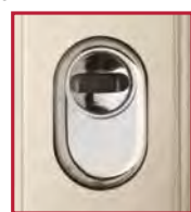
Osłona antywyważeniowa zamka głównego
